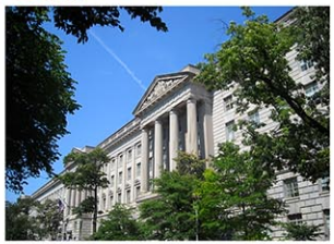
ワシントン D.C. にある米商務省のビル (photo: AgnosticPreachersKid / https://commons.wikimedia.org/wiki/User:APK)
